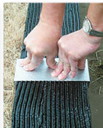
Zatlačení stykového plechu
