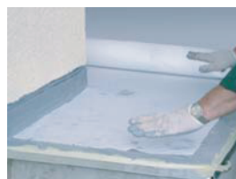
3. Vložit a zatlačit vlísovou vložku
