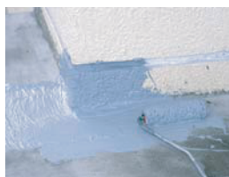
2. Nanést silnou vrstvu jako lůžko pro vlísovou vložku
