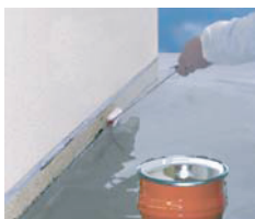
1. Válečkem nanést penetrační nátěr
